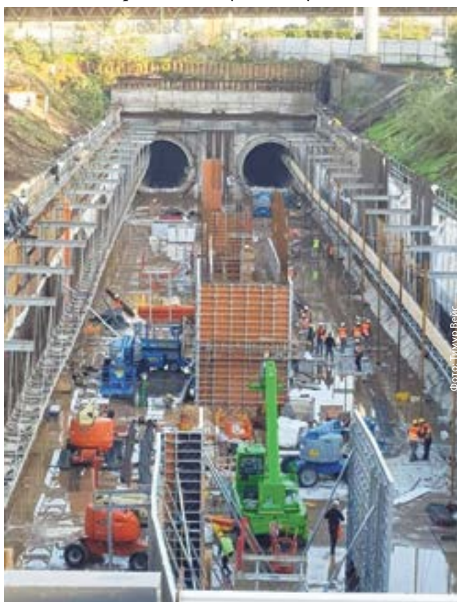
Строительство станции метротрамвая «Эм ха-Мошавот» (Петах-Тиква)
