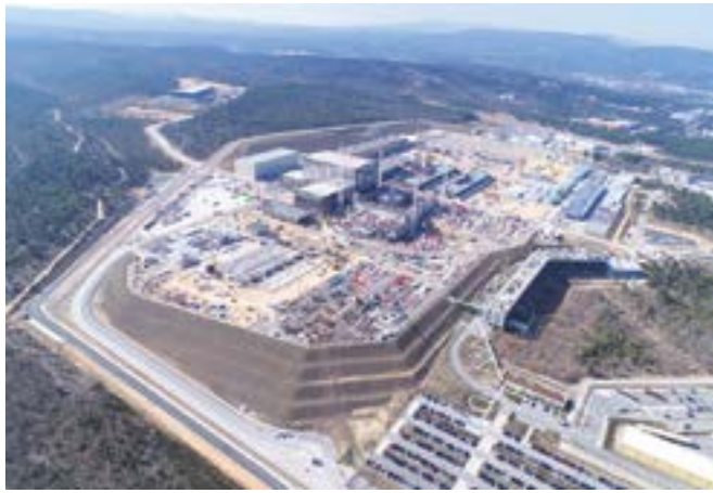
Аэрофотоснимок площадки ITER на этапе строительства (2018)
