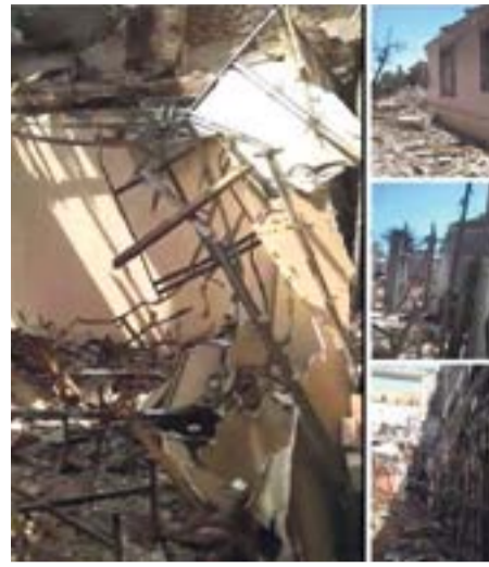
Так выглядит разрушенная синагога в Мприуполе
