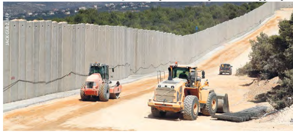
Строительство заградительного сооружения на израильско-ливанской границе
