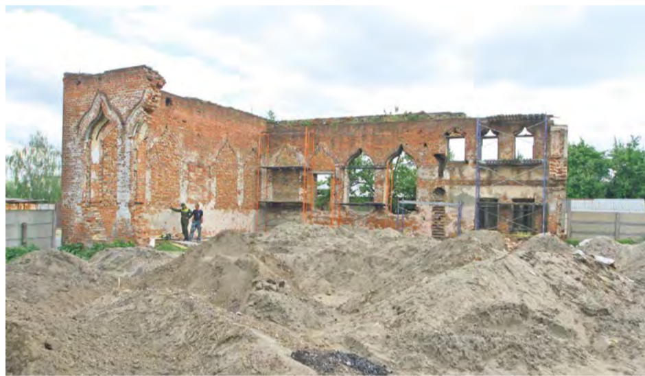
Идут строительные работы
