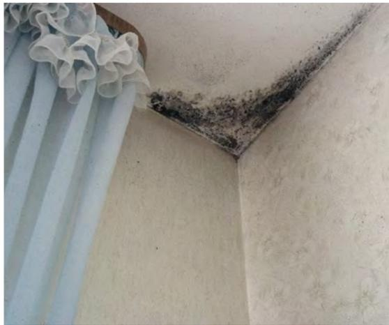
чено, что недостаточная гидроизоляция фундамента не защищает стены от грунтовой влаги. Причинами появления плесени могут служить и так называемые «тепловые мостики», нередко образующиеся рядом с оконными рамами, в нишах для батарей отопления и во всех прочих местах, где возможна ускоренная передача внутреннего тепла из квартиры наружу. Проблемой могут стать и современные хорошо изолированные окна, установленные в домах старой постройки без устройства дополнительной теплоизоляции наружных стен.
